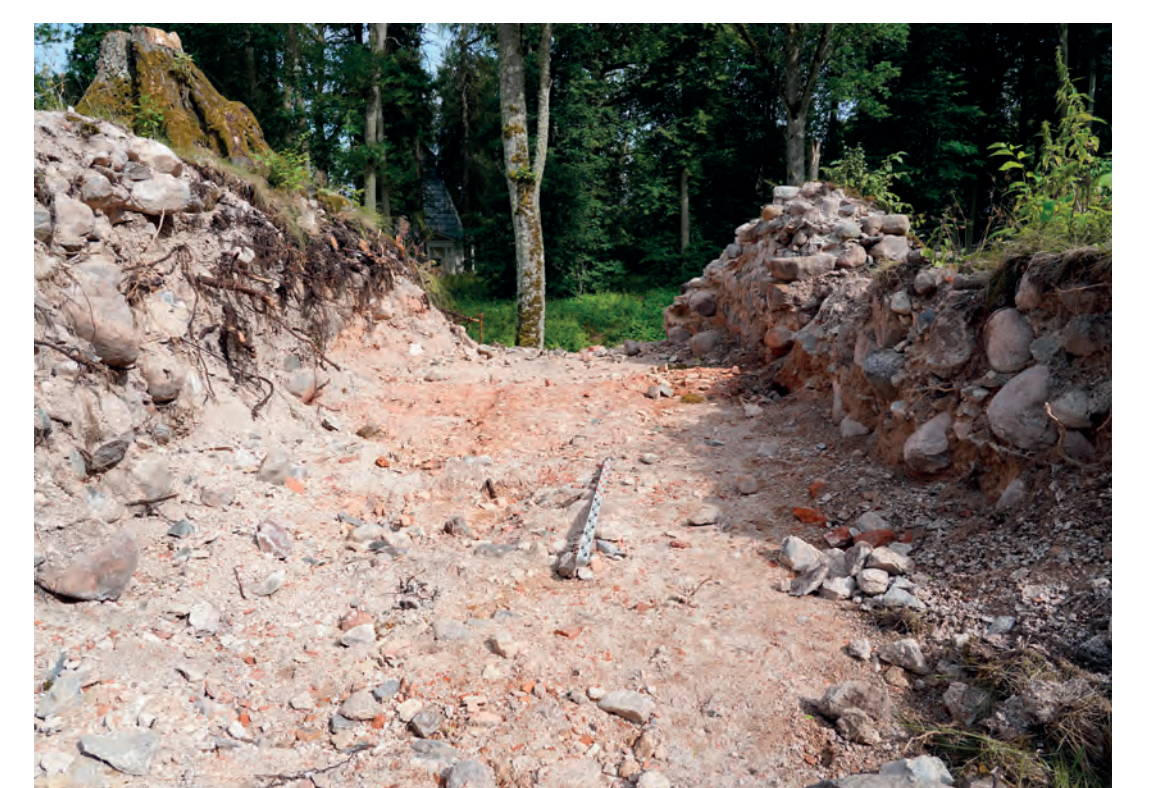
■ Vaade väravakäiku linnuse idaküljel. Tõenäoliselt lasti värav õhku ja sedavõrd suure laenguga, et plahvatus killustas väravakäigu paekividest detaile, pulbristas ja sulatas telliseid ning pööras segi isegi looduslikku moreeni väravakäigu all. FOTO: AIVAR KRIISKA
